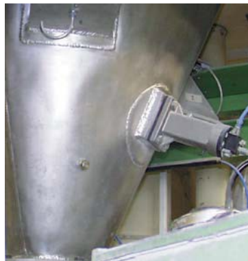
Rengöring av silo väggar
