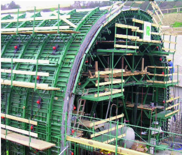
Tunnelform med pneumatiska vibratorer Serie NVT
