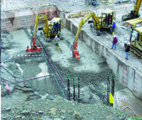
Tyst vibrering av element av betong med vibrationsbord samt serie GyroShake®
