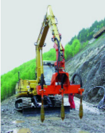
Grävmaskin bestyckad med hydrauliska stavvibratorer Serie NHR. För vibrering av stora mängder betong.
