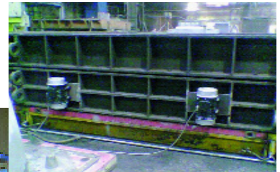
Vibrering av betong på en stålform med elektriska vibratorer serie NEG
