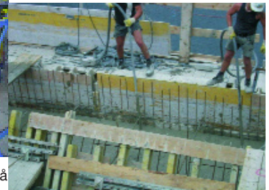
Vibrering av betong vid byggnad av ett höghus med stavvibratorer serie NCZ
